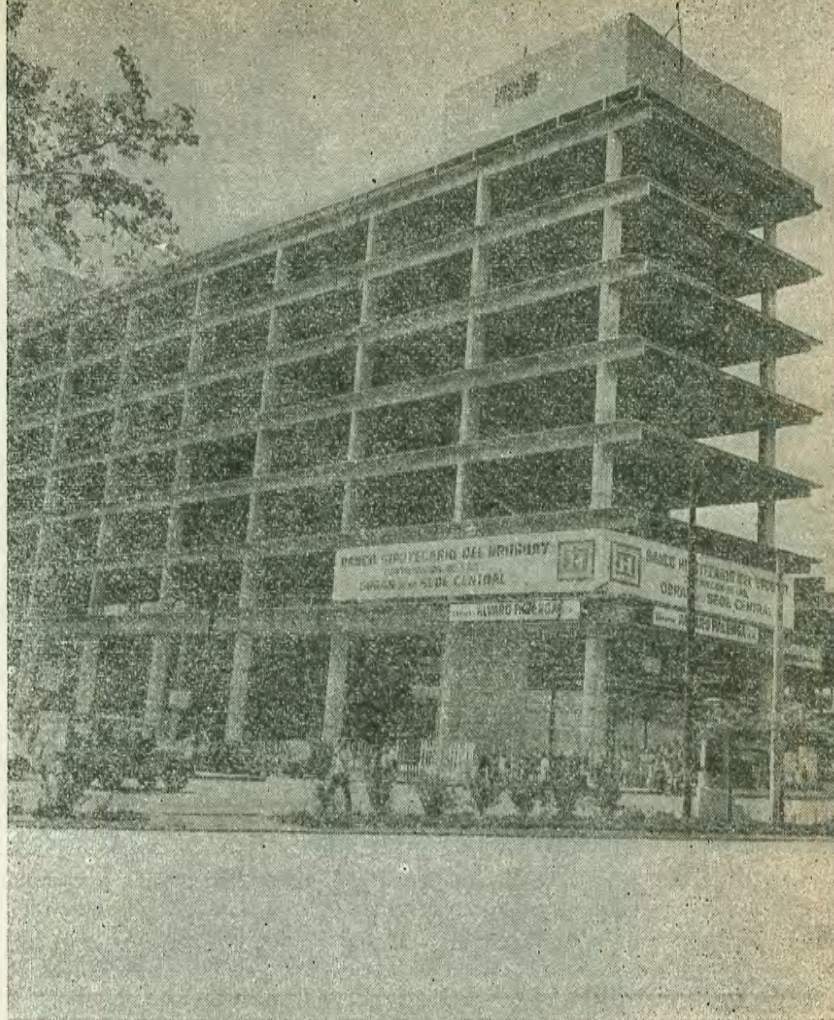
el edificio del banco hipotecario ha reiniciado sus obras.
