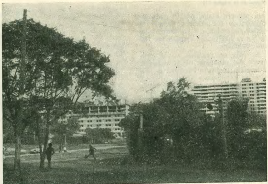
parque posadas conjunto de 2.051 viviendas en torres de 15 pisos, en construcción.
