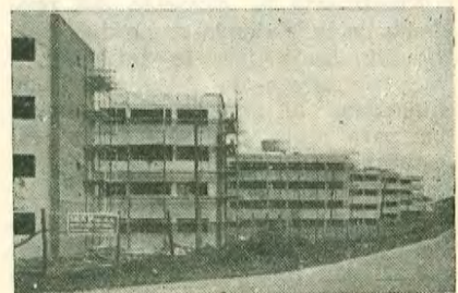
conjunto municipal de centenario para 628 viviendas en bloques de 4 pisos, en construcción.
