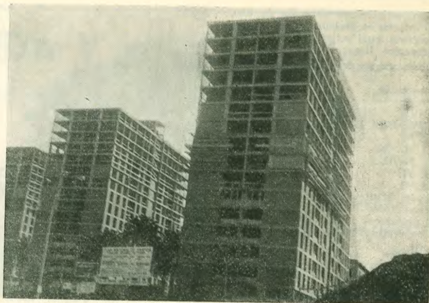
Las 600 viviendas del barrio sur del municipio en construcción, en torres de 15 pisos.
