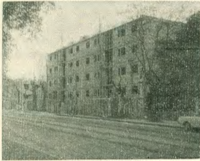
jardín de botafogo en castro y hornos para 160 viviendas en construcción.
