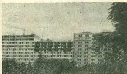
parque posadas estado actual de las obras.
